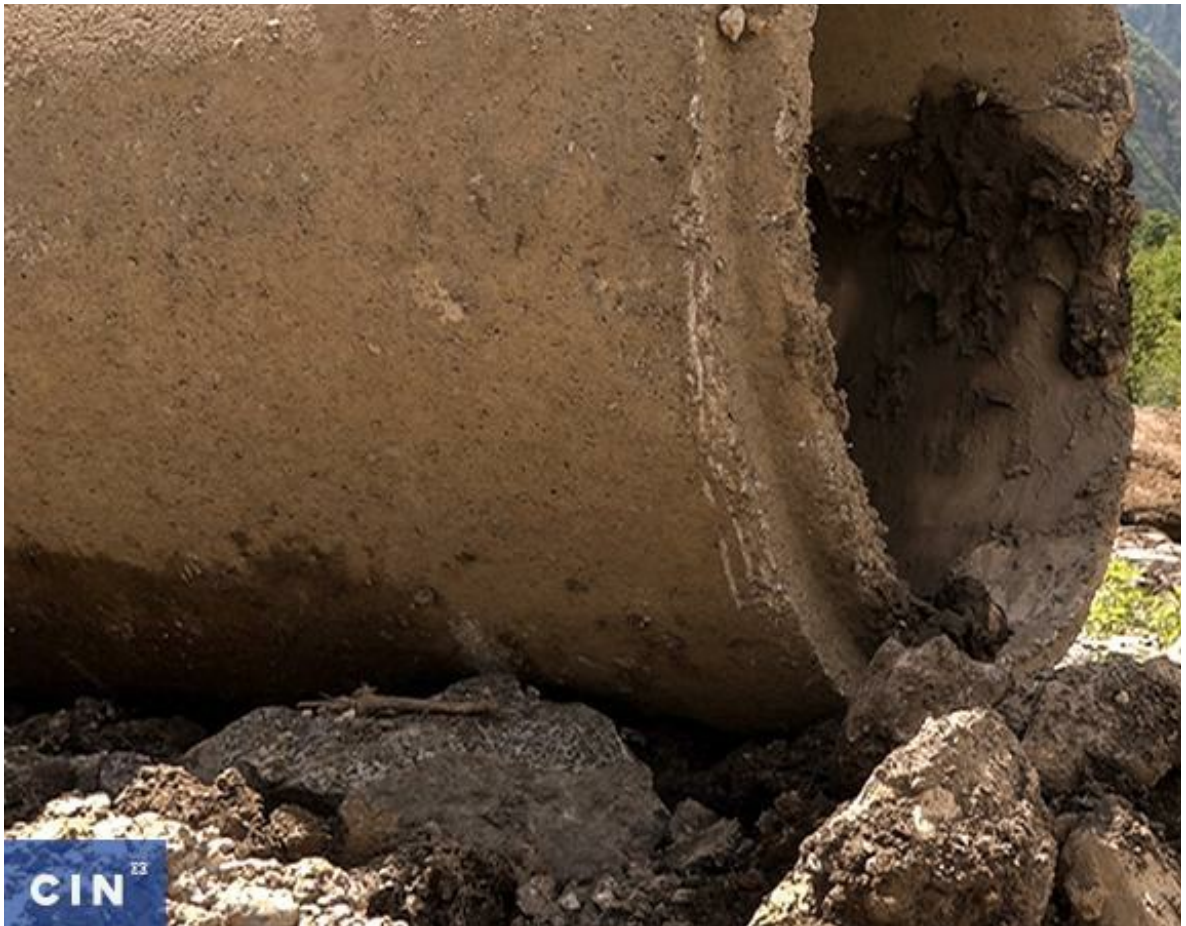
Stare kanalizacijske cijevi zamjenjuju se za nove
